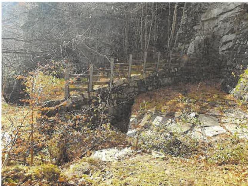
**Foto n. 11 – Bacino di dissipazione e muro d'ala bordo destro**
