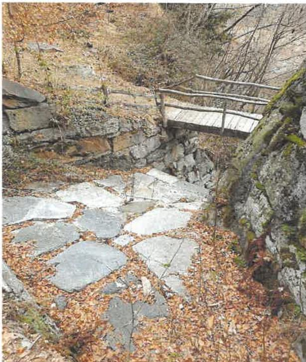
Foto n. 12 – Bacino di dissipazione, muro d'ala bordo sinistro e ponticello
