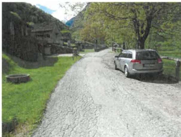
Foto 2: Stato strada tratta pozzetti 30-31
