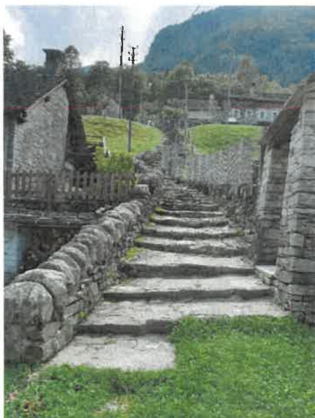
Foto 3: Sentiero tratta pozzetti 29-30
