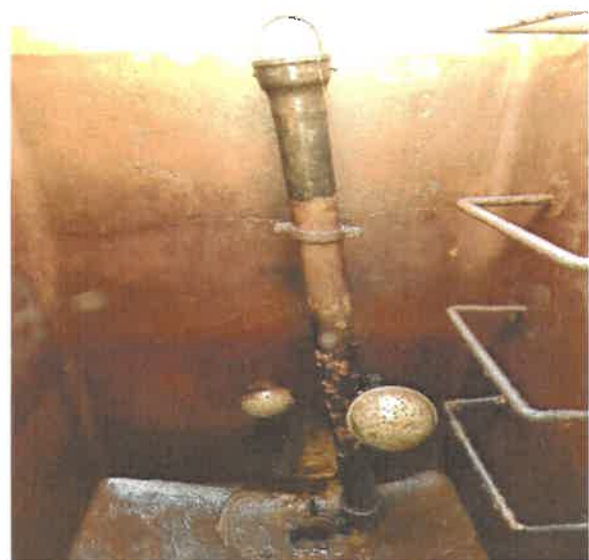
Camera di raccolta. Vista interna
