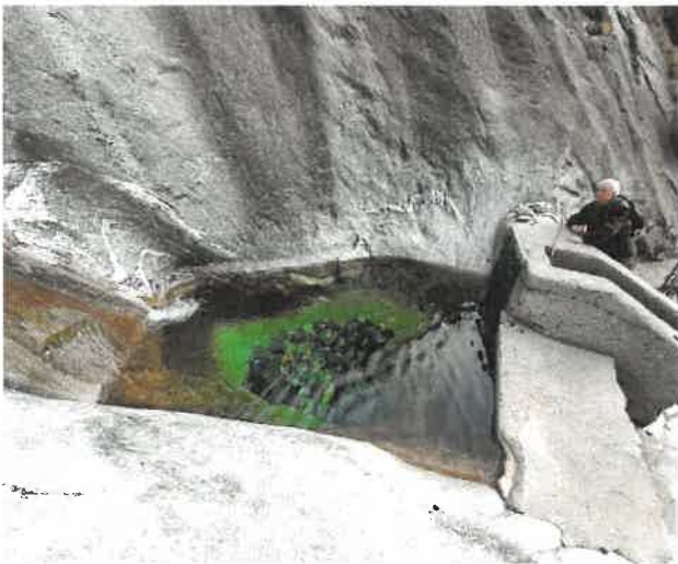
Manufatto di captazione attuale
