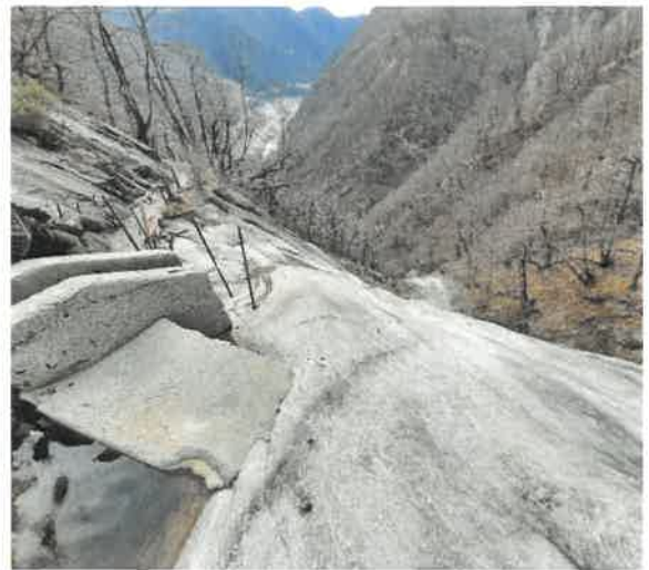
Manufatto di captazione attuale. Vista valle
