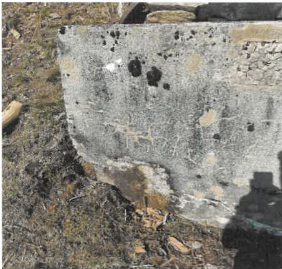
Camera di raccolta. Vista esterna
