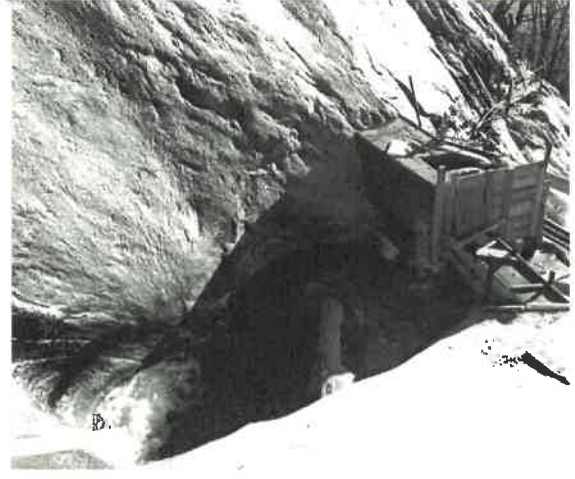
Costruzione manufatto di captazione attuale
